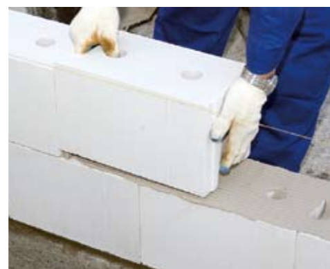
Murowanie na zaprawę cienkospoinową przebiega sprawnie i czysto. Obniża także koszty inwestycji.
