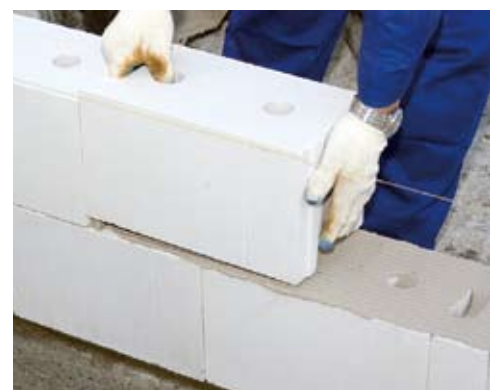
Murowanie na zaprawę cienkospoinową przebiega sprawnie i czysto. Obniża także koszty inwestycji.
