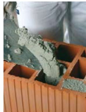
Wypełnienie zaprawą murarską otworów pustaka Porotherm 25 AKU
