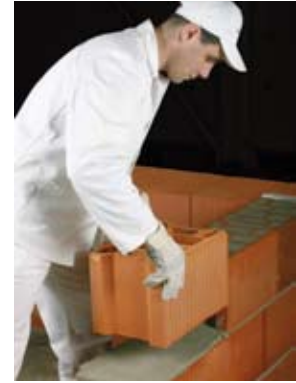
Murowanie ściany z pustaków Porotherm 25 AKU na zaprawie cementowo-wapiennej
