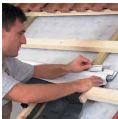
Montaż rynienki do odprowadzenia wody
