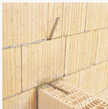
Kotwienie ściany działowej
