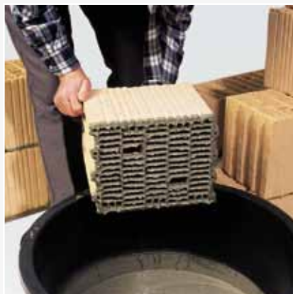
Metoda klejenia Thermoporu szlifowanego. Pustak lekko moczony w zaprawie klejowej do 0,5 cm wysokości.
