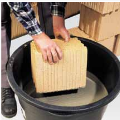
Metoda klejenia Thermoporu szlifowanego. Pustak lekko moczony w zaprawie klejowej do 0,5 cm wysokości.
