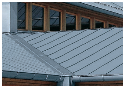
Kosz z rąbkim pojedynczym oraz pasem włutowanym
