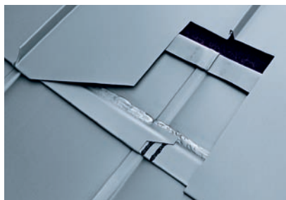
Optymalne wykonanie: dodatkowy pas wlutowany
