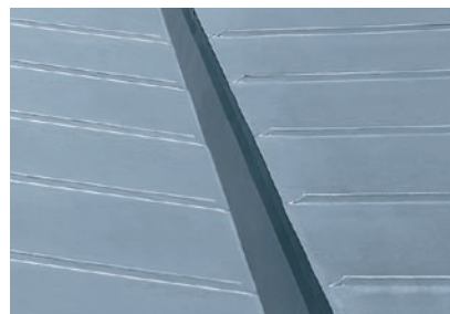
Rynna wewnętrzna skrzynkowa z wyklejaną rynną zabezpieczającą
