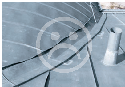
Kosz z bocznymi połączeniami na rąbek
