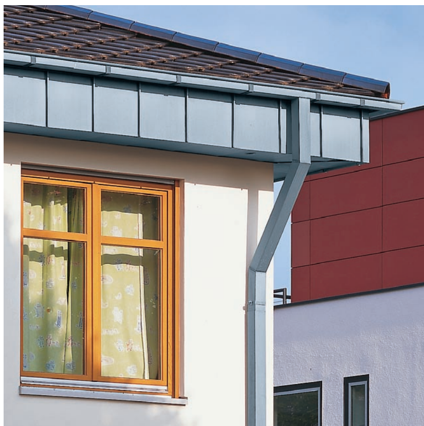
Rura spustowa półokrągła, wysokoczęstotliwościowo spawana, patent europ. 0284141, 3 m (inne długości na zamówienie)
