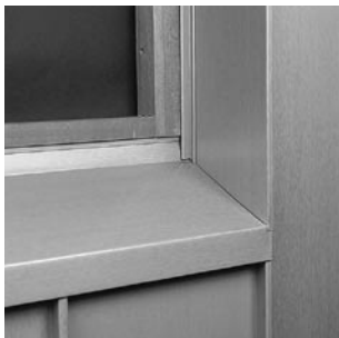
Fot. 21: Boczne połączenie obróbki okna z parapetem
