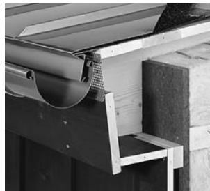
Fot. 8: Zastosowanie: detal okapu (podwójny rąbek stojący) z matą strukturalną
