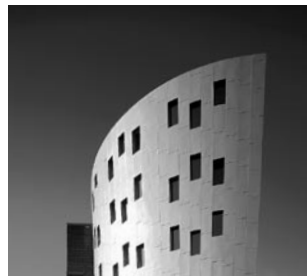
Fot. 6: RHEINZINK® - wielkie łuski przyklejone do metalowej podkonstrukcji klejem poliuretanowym
