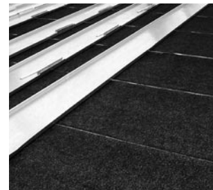
Fot. 9: Maty strukturalne z membraną, układane na deskowaniu
