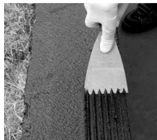
Fot. 5: Enkolit® - rozprowadzanie szpachlą zębatą
