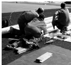
Fot. 8: Zastosowanie: detal okapu (podwójny rąbek stojący) z matą strukturalną
