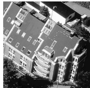
Fot. 26: Obróbki attyk i gzymsów
