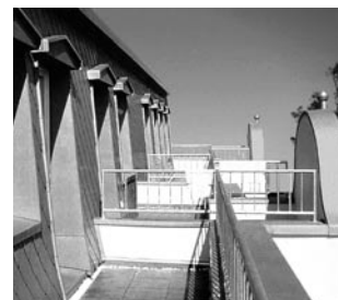
Fot. 25: Zastosowanie obróbek RHEINZINK® jako okładziny muru
