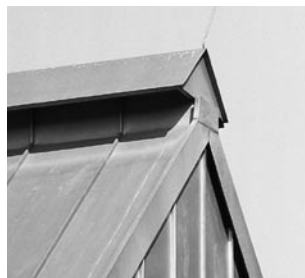
Szkic 11.1: Kalenica dachu dwuspadowego, wariant wykonawczy: wykonanie wysokie z przekrojami wentylacyjnymi
