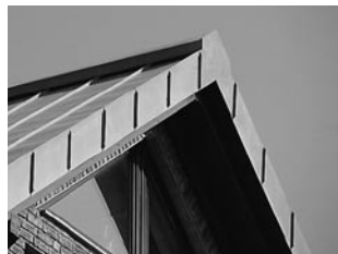
Fot. 13: Zakończenie kalenicy równo z wiatrownicą felcowaną, wariant niski
