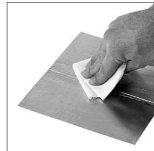
Fot. 16: Oczyszczanie zabrudzeń po lutowaniu
