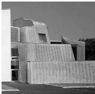
Fot. 1: Blacha RHEINZINK®-gotowalцовana, budynek administracyjny VITRA w Birsfelden, Szwajcaria
