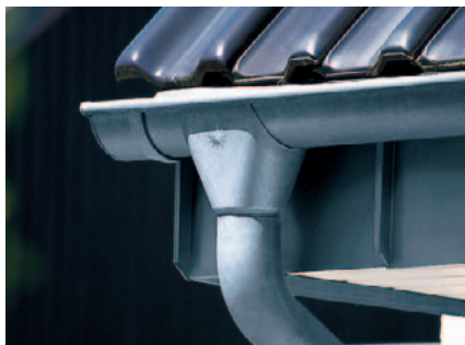
Obróbka pasa podrynnowego
