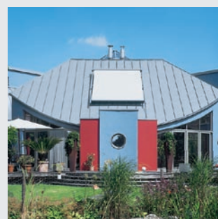
Dom mieszkalny w Bad Iburg, Niemcy
