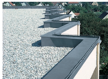
Obróbki brzegów dachu z piorunochronem
