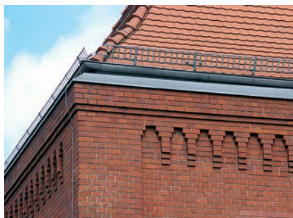
Załamanie dachu wykonane z profili gzymsowych i okapowych
