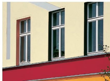
Obróbki parapetów i gzymsów
