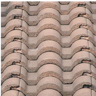
dach po oczyszczeniu środkiem DIMOUSSE
