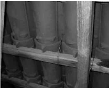
Prawidłowo wykonane zaczepienie spinką burzową „typ długi”
