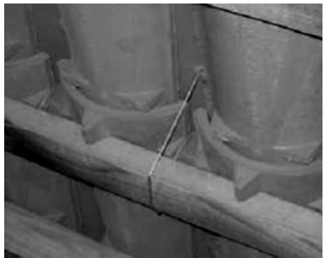
Prawidłowo wykonane zaczepienie spinką burzową „typ długi”
