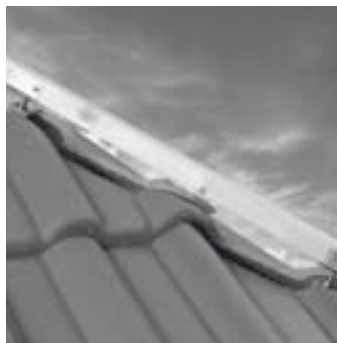
2. Zamontować latwę na gradzie.
