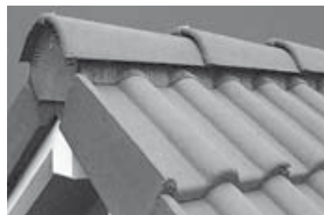
6. Gotowe ukształtowanie grzbietu dachu z wywietrznikiem - umożliwia odpowiedni optycznie przebieg kalenicy.
