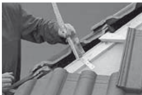
2. Sprawdzić wysokość listwy, narożnik dachu i zamontować chwytaکی.
