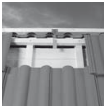
1. Zamontować latwę na kalenicę.
