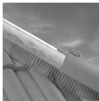
8. Prawidłowe ułożenie taśmy kalenicowej na gradzie.
