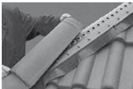
5. Ukształtowanie narożnika dachu następuje analogicznie jak przy montażu kalenicy.
