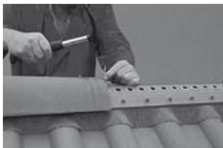
4. Sukcesywny montaż wywietrznika do kalenicy.
